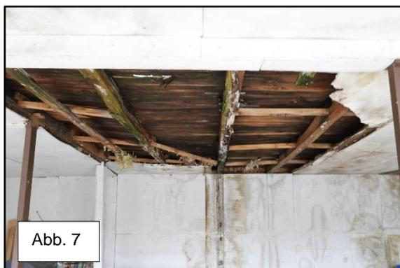
Abb. 7 bis Abb 9: Das Nebengebäude auf dem Flurstück 239/25 ist marode. Es dringt zum Teil Wasser ein. Es ist feucht und zugig.
