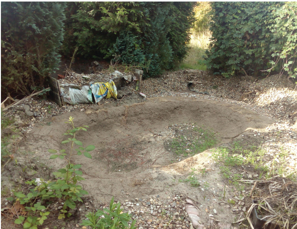
Bild 2: Bereits zurückgebauter Folienteich
